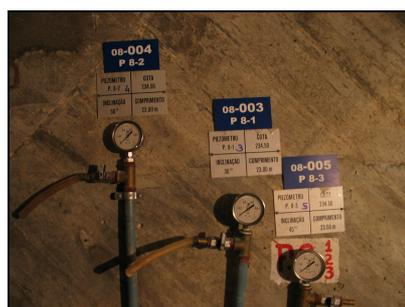
Manómetros de um leque piezométrico
