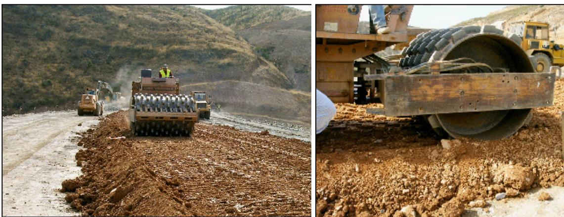
**Fig. 3.19 – Cilindro de pés de carneiro (visita técnica à Barragem de Odelouca).**
