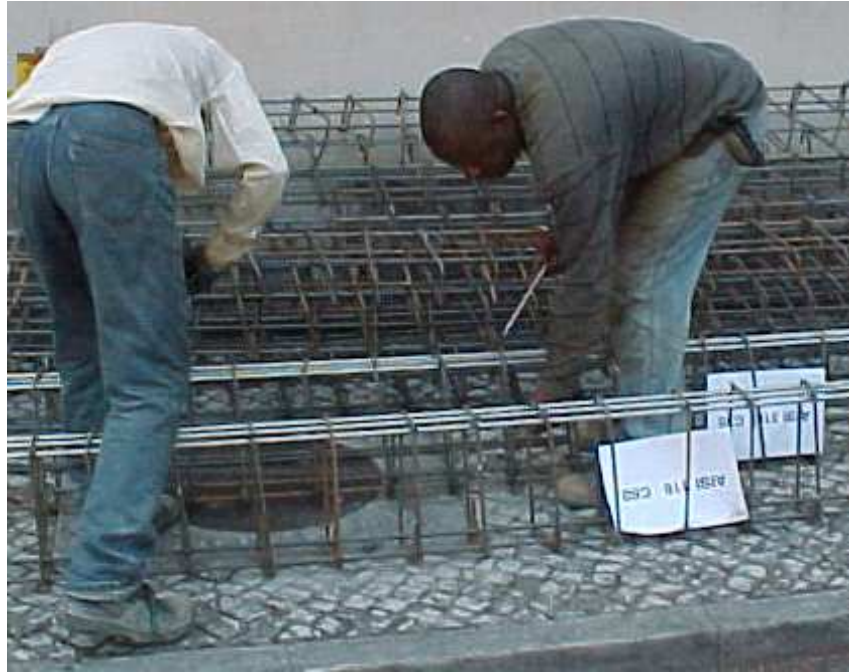
Figura 3-9 - Montagem das armaduras.
