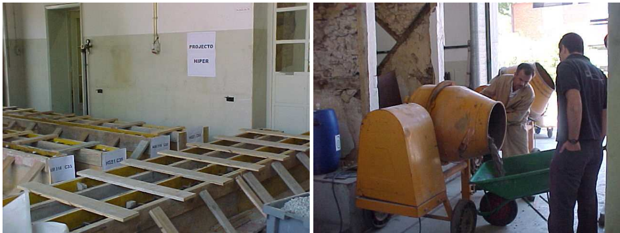
Figura 3-10 - Aspecto geral da cofragem e da execução do betão.
