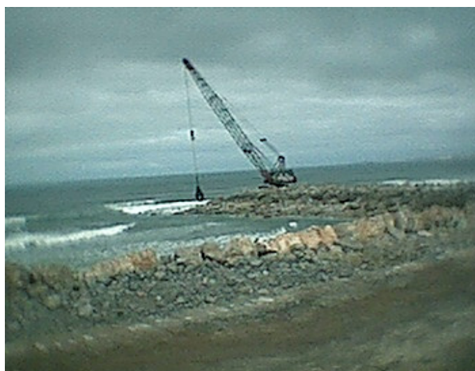
Foto 4: Obras de defesa da linha da costa do lado Sul (obras em finais de Abril de 2005. Espaço entre os esporões números 4 e 5)
