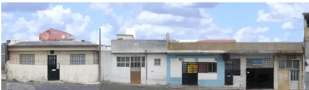
Figura 4 – Conjunto urbano de edifícios de um piso - Rua 8 de Dezembro (Fonte: DIBA)
