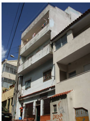
Figura 2 – Edifício de 5 pisos
