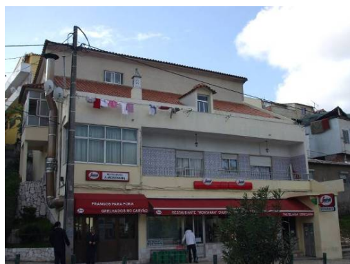
Figura 3 – Edifício de 4 pisos
