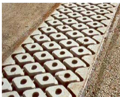
Fig. 34 - Juntas de perfis de elastómero múltiplos, com placas rômbricas
