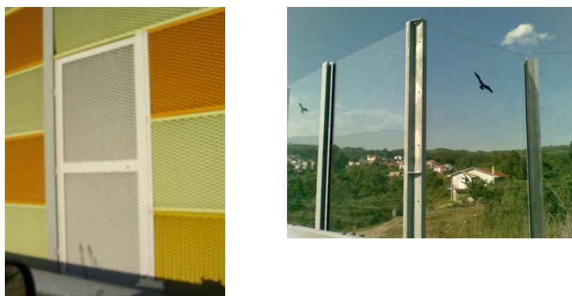
Fig. 31- Exemplos de aspectos de segurança a ter em conta no planeamento de barreiras acústicas
