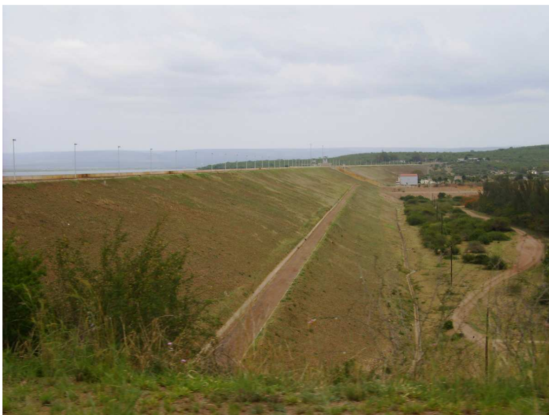
Fig 1-Vista de jusante da MD da barragem dos Pequenos Libombos
