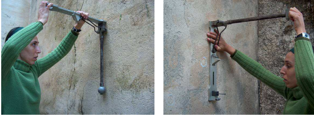
Fig. 12 – Ensaio de choque de esfera e de penetração controlada
