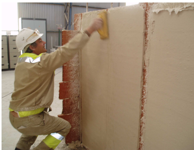
Fig. 19 – Aplicação experimental sobre um murete
