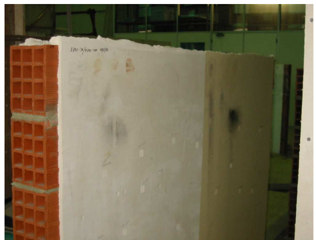
Fig. 20 – Murete após ensaios de resistência às acções de degradação devidas ao uso
