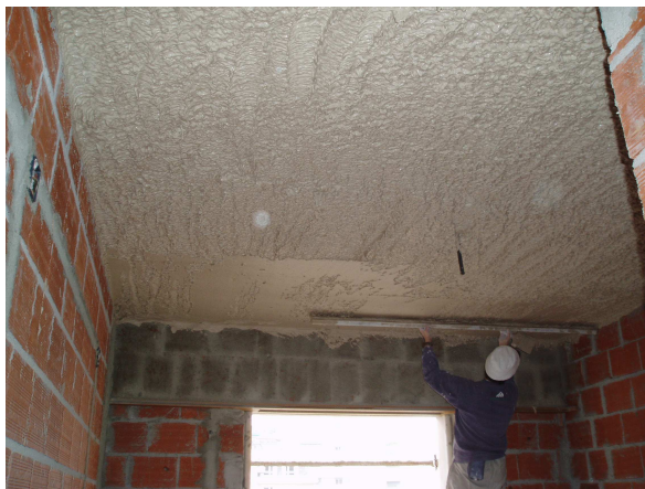
Fig. 1 – Aplicação de revestimento pré-doseado de gesso: máquina de projecção.
