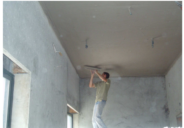
Fig. 4 – Operações de acabamento em revestimento de gesso aplicado em paredes e tectos.
