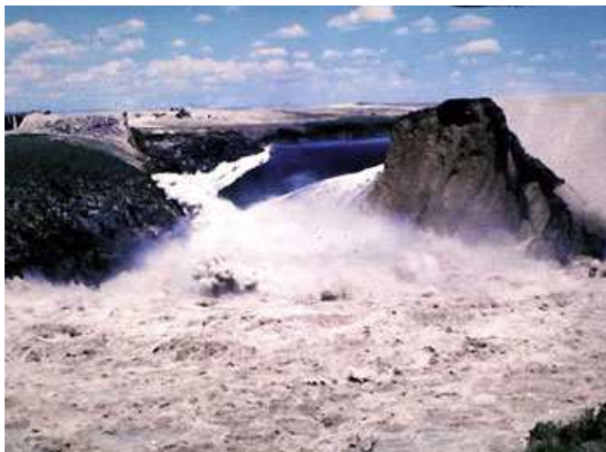
Figura 2.5 – Formação de brecha da barragem de Teton , 1976 (foto retirada de [30])
