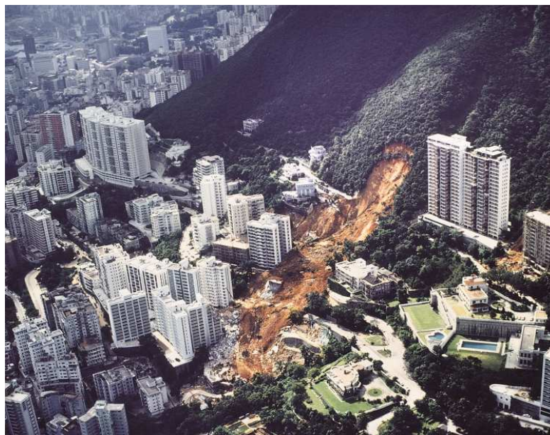
Figura 2.13 – Escorregamento de um talude natural (Po Shan Road landslide, Mid-levels, Hong Kong Island, retirado de [39])
