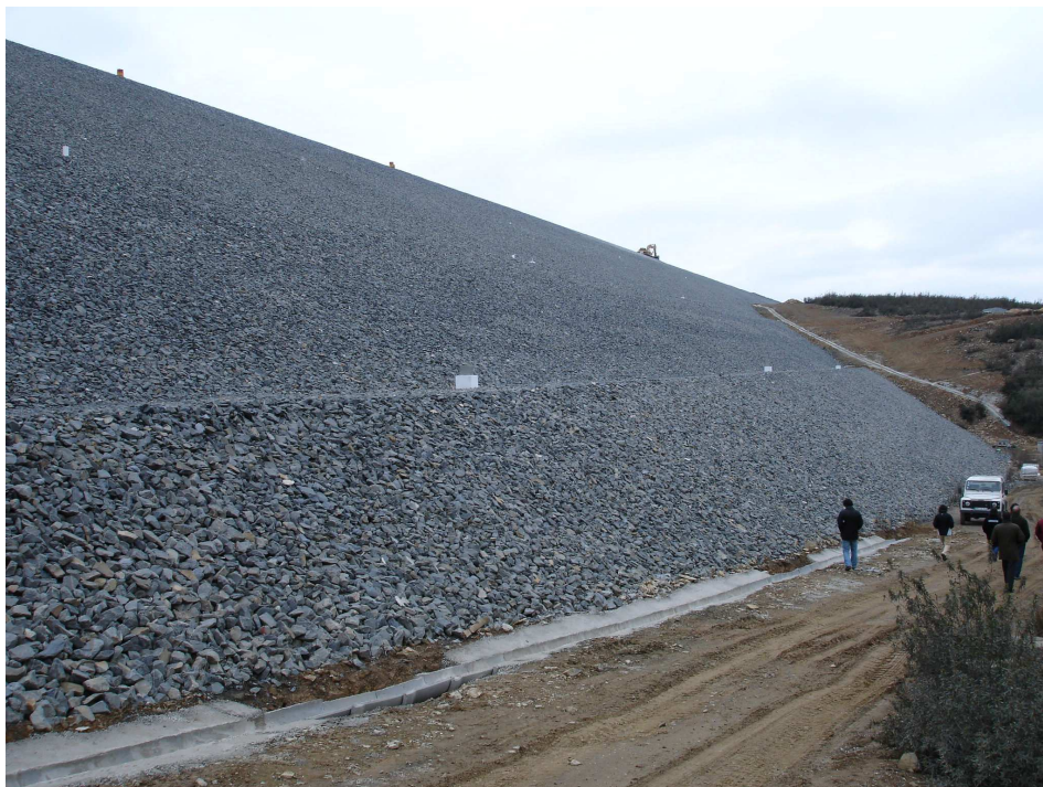
Figura 7.13 – Vista de jusante na zona de maior altura da barragem principal
