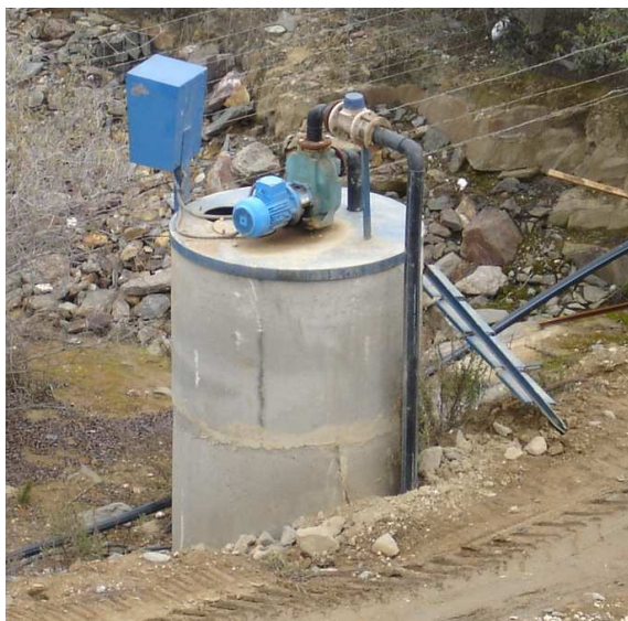
Figura 7.15 – Poço de drenagem/bombagem - IBR
