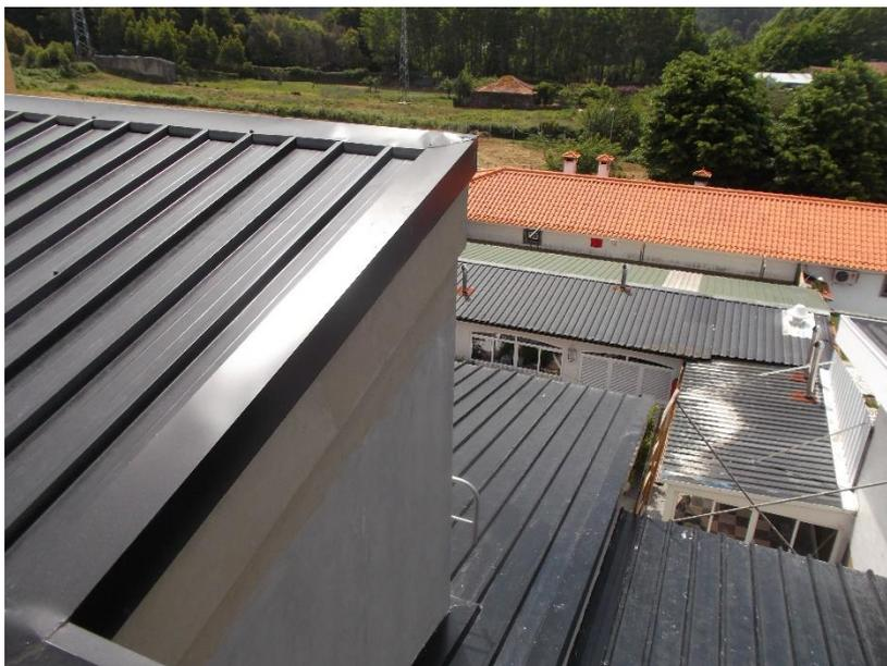
Figura 3.19 Painéis *sandwich*
