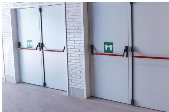
Figura 3.26 Portas corta-fogo (Fonte: <https://www.univerautomatic.com/portas-corta-fogo-santarem/>)
