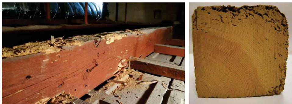
Figura 5 – Vigamento com degradação generalizada por carunchos
