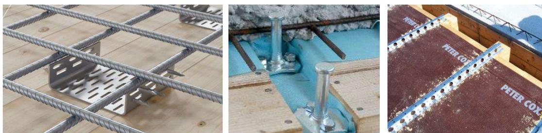
Figura 1 – Algumas ligações usadas em pavimentos mistos madeira-betão
