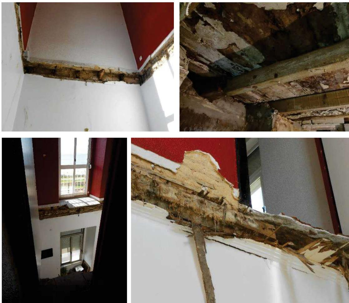
Figura 9 – Pavimento que colapsou após adição de betonilha e apodrecimento da madeira
