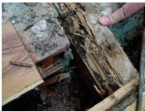
Figura 6 – Vigamento com degradação por térmitas de madeira seca
