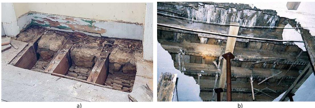
Figura 3 – Degradação por fungos de podridão afetando unicamente as entregas húmidas (a) e generalizada a todo o vigamento de uma laje de esteira sob cobertura em mau estado (b)
