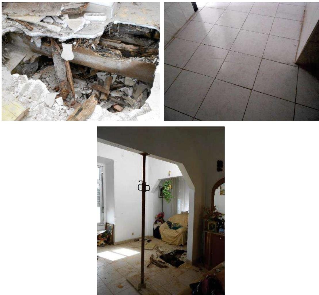
Figura 10 – Pavimento em que a madeira apodreceu, após adição de betonilha, com sinais de rotura e cedência em diversos pontos
