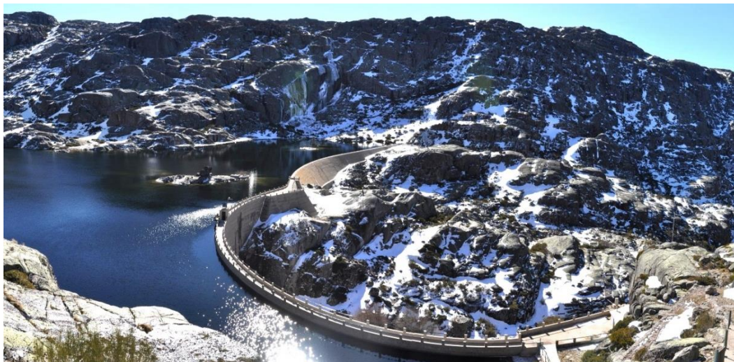
Figura 1. Barragem do Covão do Meio. Vista geral a partir da encosta da margem direita
