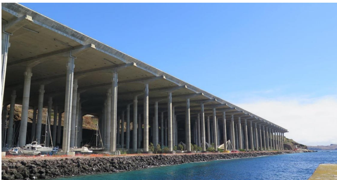
Figura 3.10 – Estrutura de ampliação da pista do Aeroporto da Madeira
