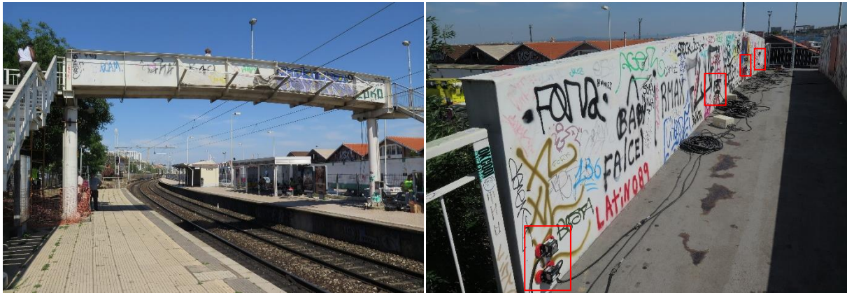
Figura 3.8 – Ensaio de vibração ambiente da Passagem Superior Pedonal, na estação de Santos da linha de Cascais
