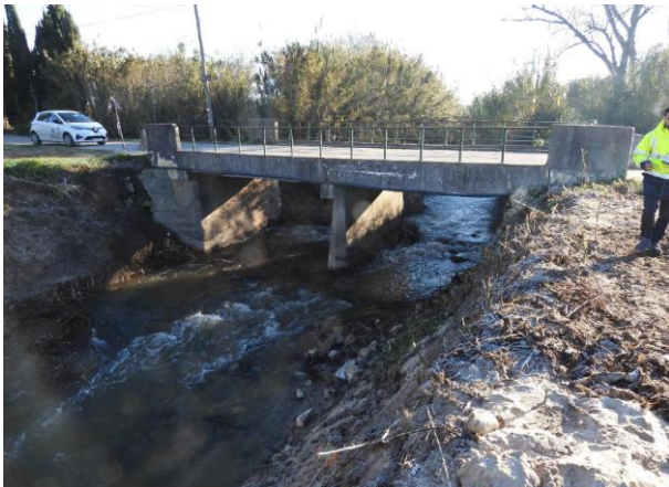
Figura 3.12 – Ponte s/Rio da Areia, em Valado dos Frades
