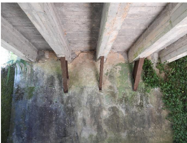
Figura 3.14 – Ponte do rio de Porto, em Amiais de Baixo
