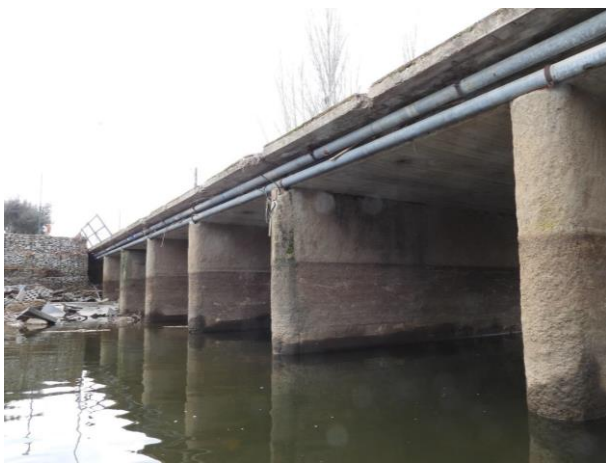
Figura 3.13 – Ponte sobre a Ribeira Grande, em Avis
