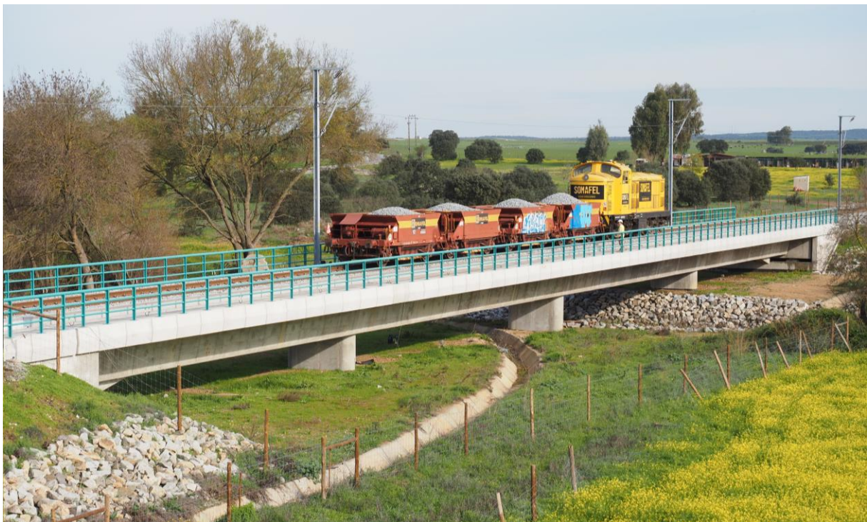
Figura 3.9 – Ensaio da ponte do Degebe, na Linha de Évora, no Corredor Internacional Sul
