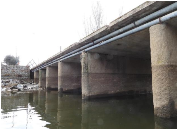
Figura 3.11 – Ponte sobre o Rio Caia, em Arronches
