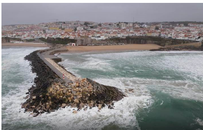
Figura 1. Quebra-mar do porto da Ericeira. Fonte: DGRM.
