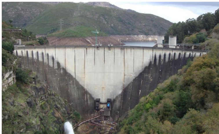
Figura 3.1 – Barragem do Alto Lindoso. Vista de jusante a partir da margem esquerda, em novembro de 2020 (LNEC; 2021)
