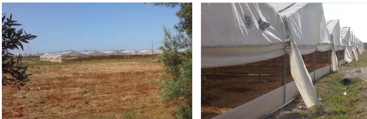
Figura 4 – Estufas na Campina de Faro e sistemas de drenagem de águas pluviais
