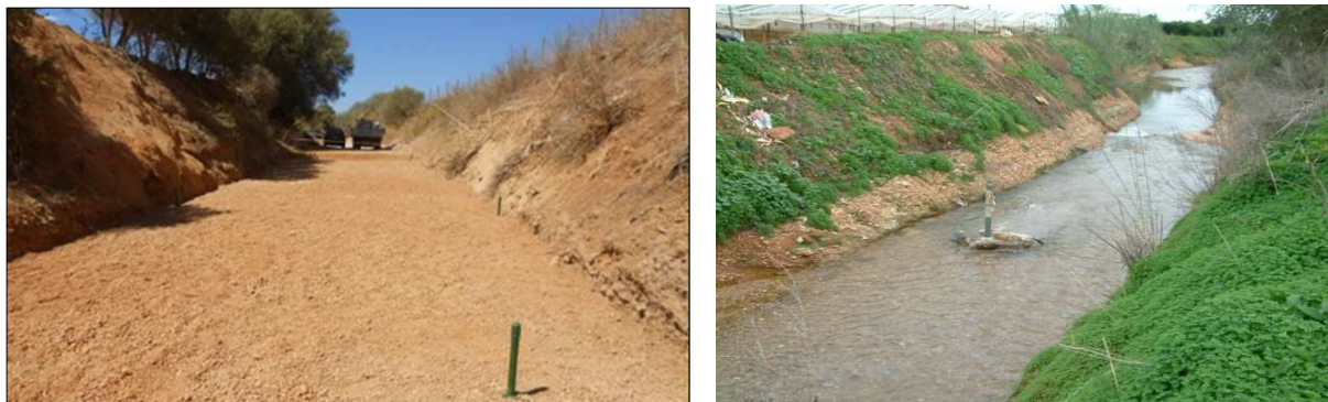
Figura 1 - Bacias de infiltração no leito do rio Seco, na Campina de Faro
