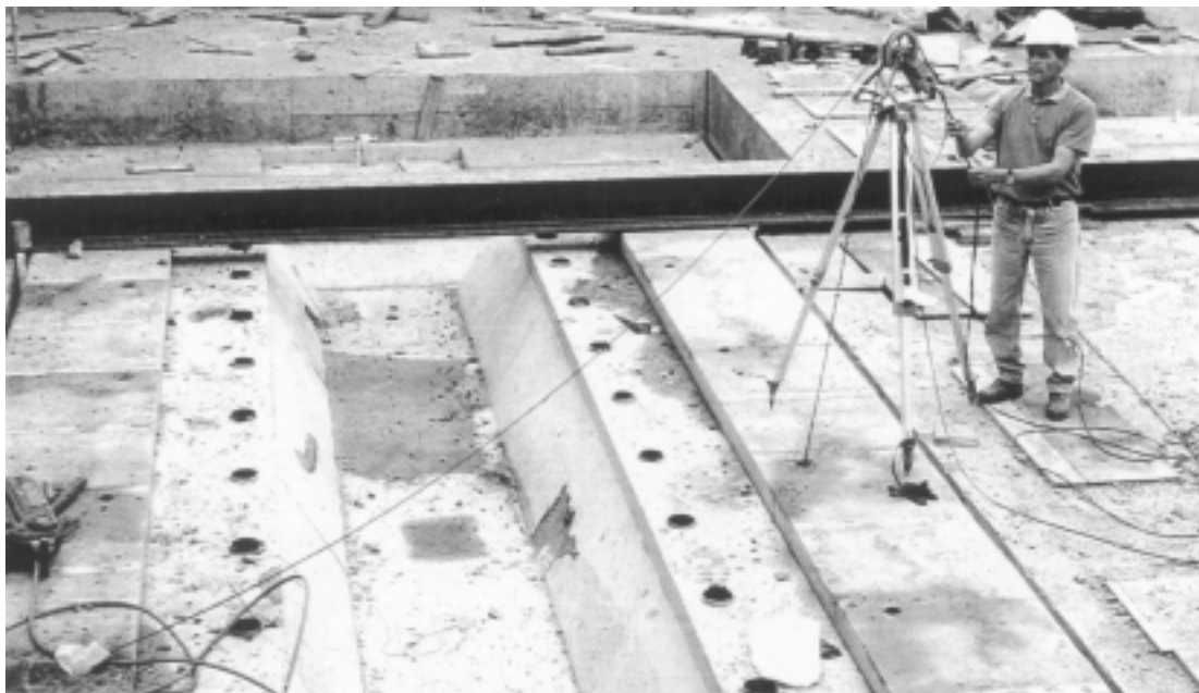
Fig. 4 – Ensaio de um maciço de betão.
