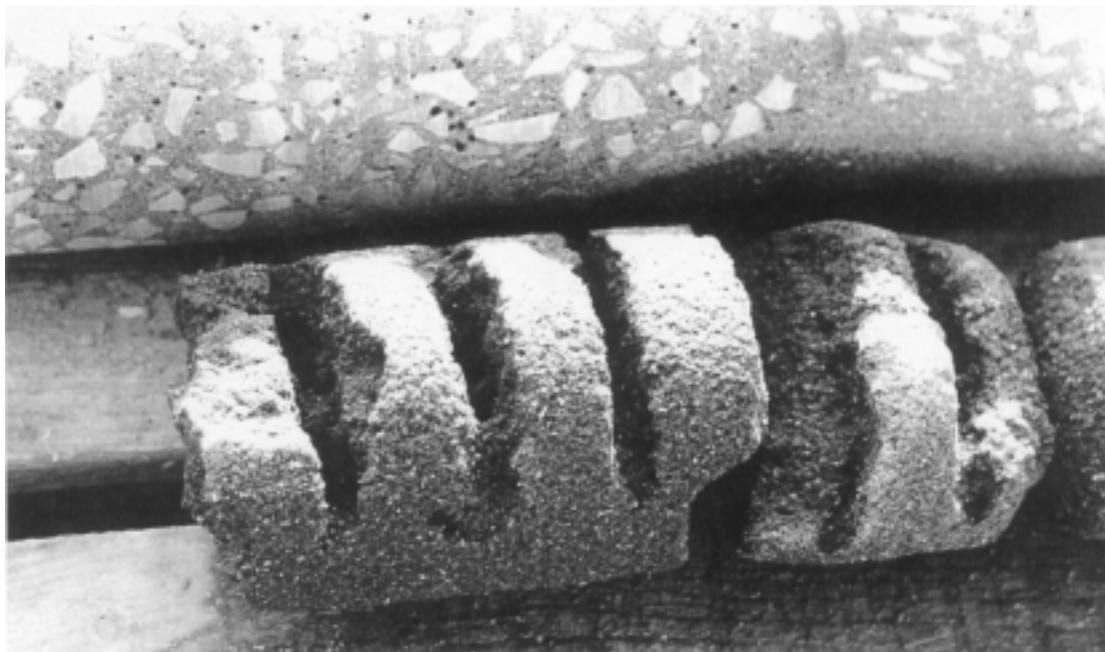
Fig. 10 – Parte dos testemunhos obtidos nas sondagens realizadas ao corpo da estaca.
