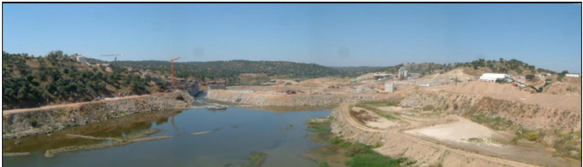
Figura 5.2 - Vista geral do local da obra em Junho de 2004 (Neves, 2004).
