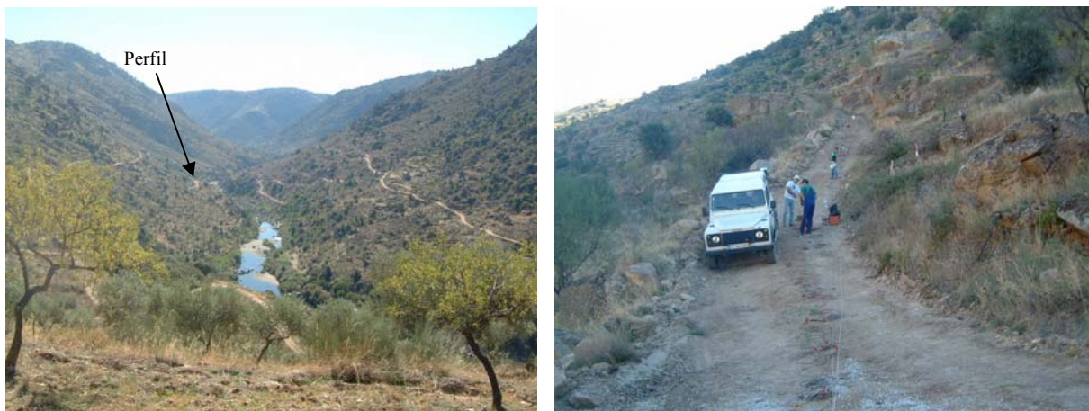
Figura 4.22 - Vista do vale do rio Sabor, de Montante para Jusante (foto da esquerda). São visíveis na Margem Direita as trincheiras abertas para a primeira fase dos trabalhos de prospecção da barragem, encontrando-se assinalada na Margem Esquerda o local onde foi realizado o perfil aqui apresentado, e documentado na figura da direita, obtida de Jusante para Montante.
