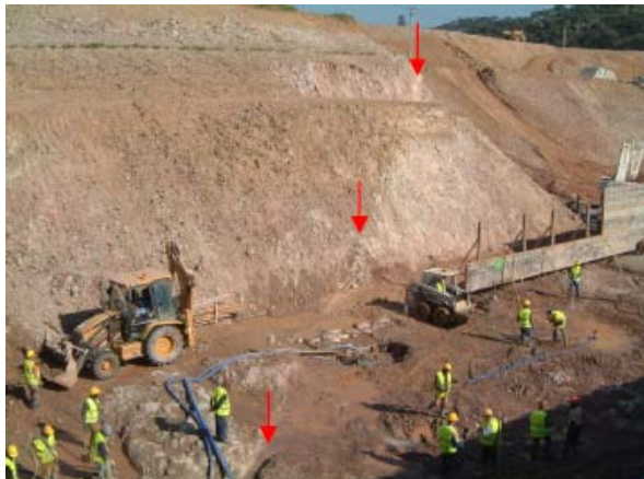
Figura 5.5 – Vista de falhas cruzadas pelos trabalhos de prospecção geofísica. A foto da esquerda corresponde ao ponto assinalado com a letra A na Figura 5.4. A foto da direita corresponde ao limite jusante (letra C) da zona de falha assinalada com as letras B e C na Figura 5.4 (Fotos retiradas de Neves (2004)).
