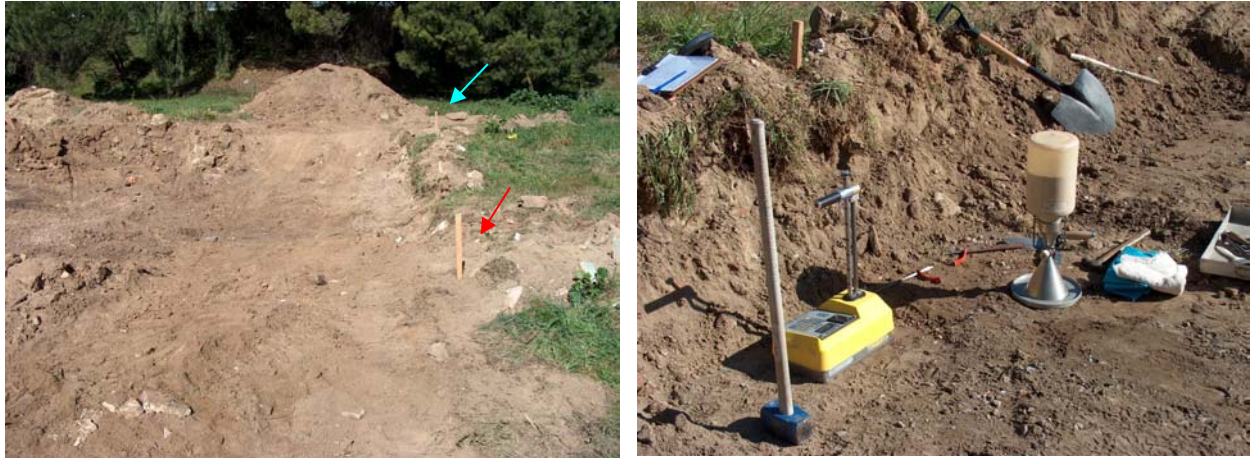
Figura 2.41 - Esquerda – Início da escavação. São visíveis a estaca indicativa do centro dos perfis (assinalada com a seta encarnada), correspondente ao local O da Figura 2.40, e a estaca colocada num dos limites laterais da escavação (assinalada com a seta azul). Direita – Aspecto dos ensaios realizados a meio da escavação.
