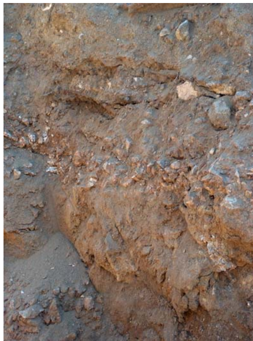
Figura 3.11 - Corte lateral do terreno. É visível a heterogeneidade do material de aterro.
