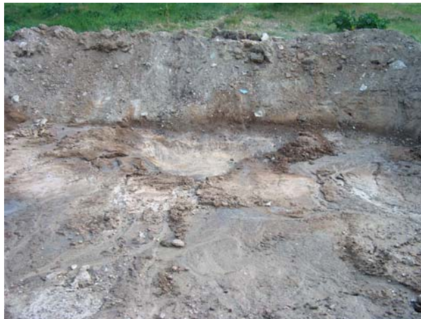
Figura 2.42 – Aspecto final da escavação executada vista de Oeste para Este, após o encharcamento da sua base, sendo identificável a caixa posteriormente cheia com pedras.
