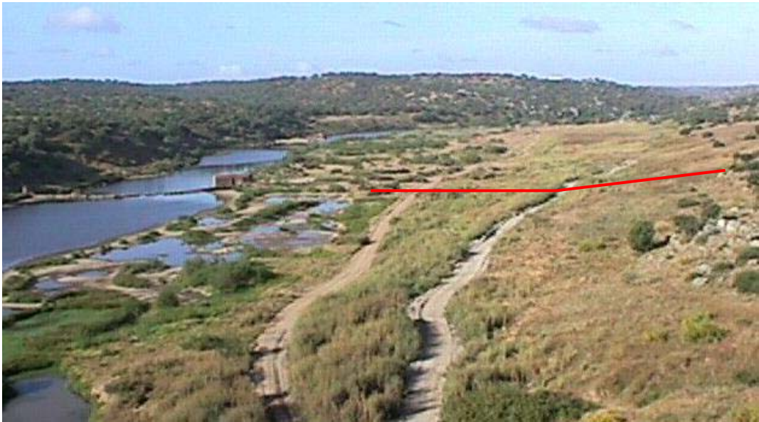
Figura 5.1 - Vista geral do local da barragem na fase de estudo (de Montante para Jusante), sendo visível o antigo Açude e o moinho desactivado. O perfil executado no eixo da barragem encontra-se marcado a encarnado (Maio 1999).
