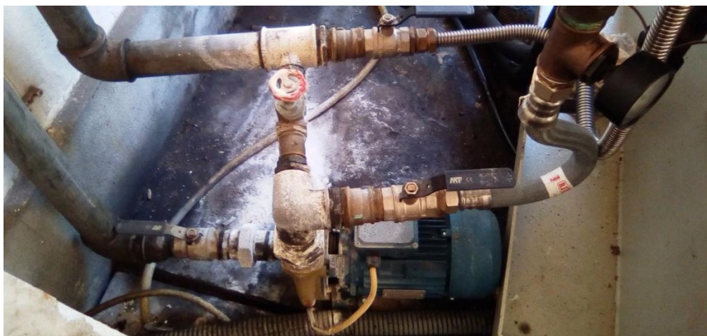
Figura 3.3 – Imagem da bomba circuladora
