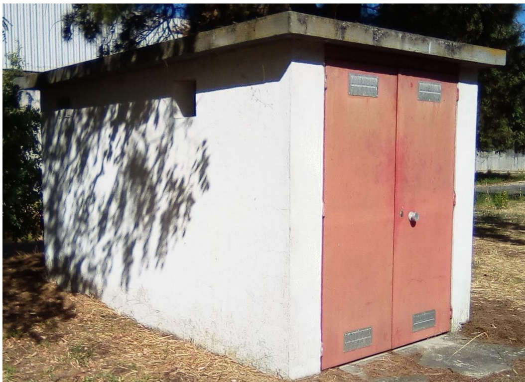
Figura 3.1 – Localização da sala do compressor Atlas Copco Airlet LE11. Vista do acesso ao compartimento da instalação de gás
