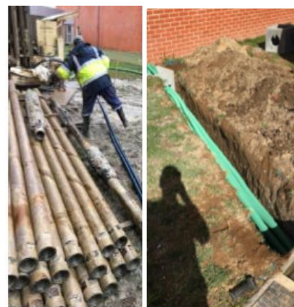
Figura 10 – Execução dos furos de monitorização
