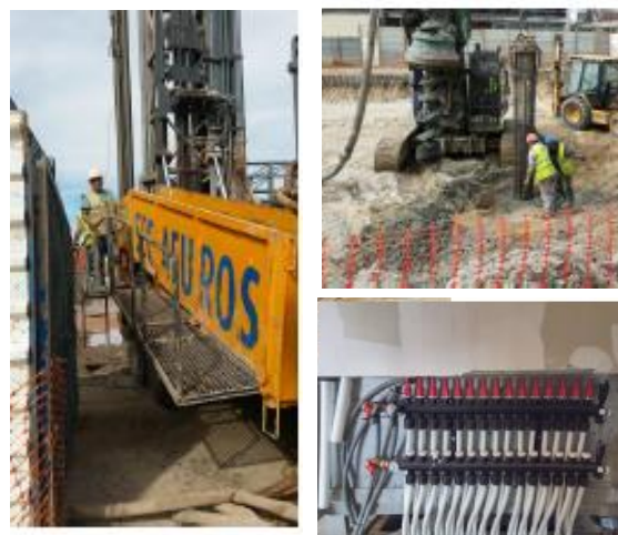
Figura 2 – Aspectos de instalação do sistema primário e das conexões dos tubos permutadores de calor do edifício CCCI
