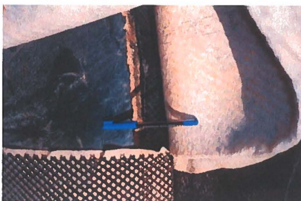
Figura 1 – Rotura por tracção de uma geomembrana localizada sob um geocompósito drenante
