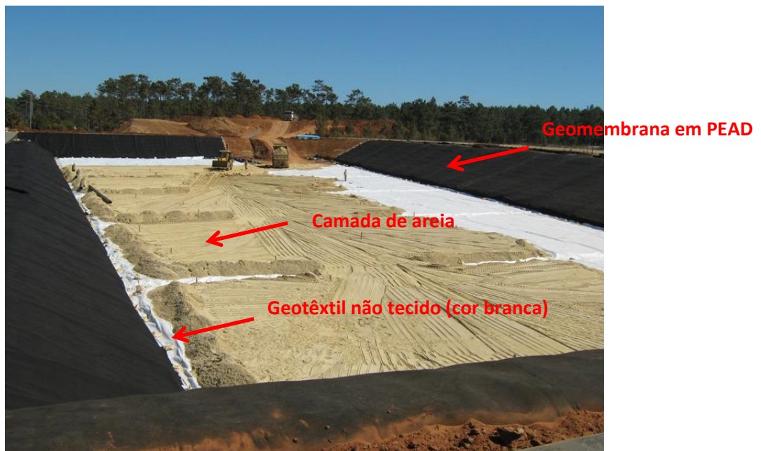
Figura 2. Aplicação da camada de areia que integra a camada de drenagem de uma célula de confinamento
