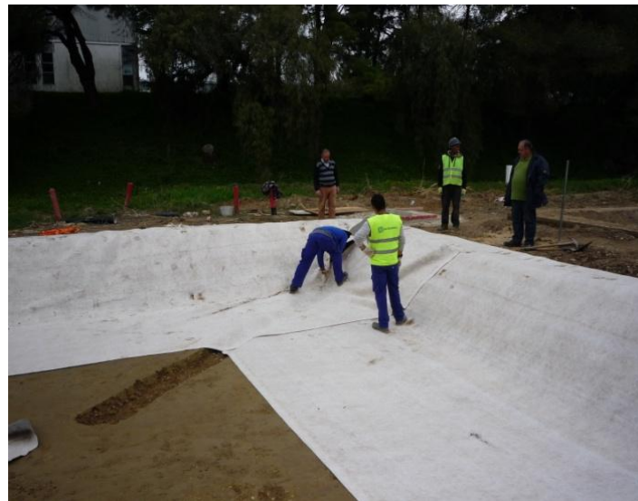
Figura 9. Aplicação do geocompósito bentonítico na célula 3
