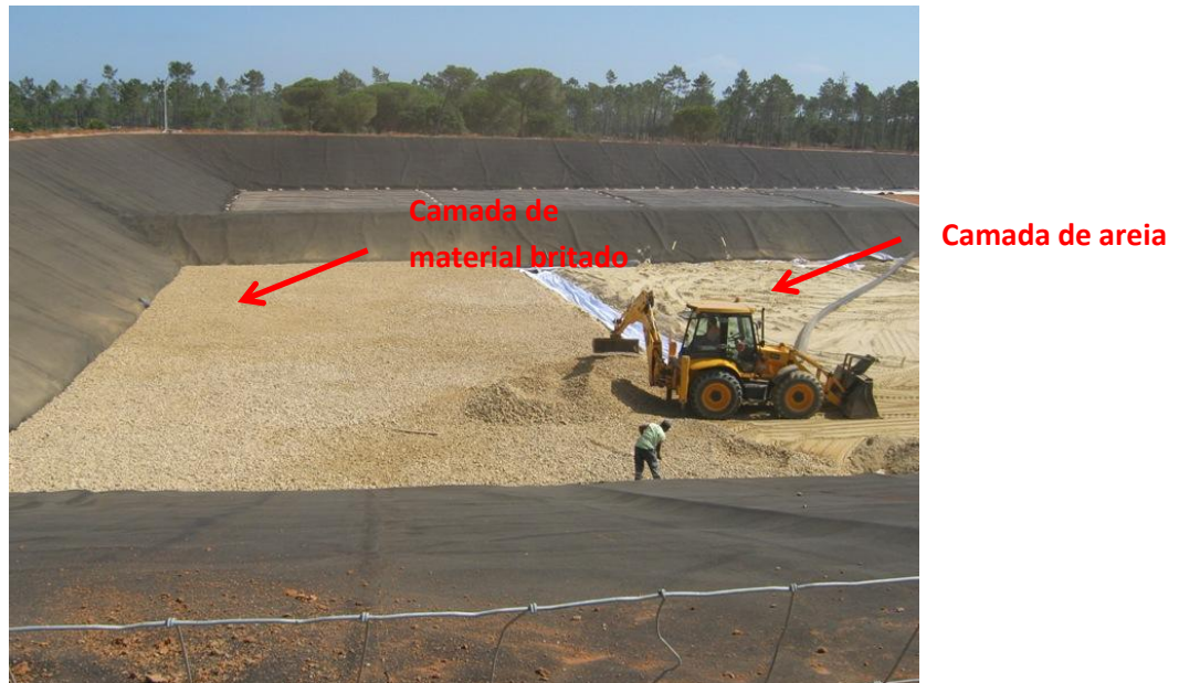
Figura 3. Aplicação da camada de drenagem de uma célula de confinamento
