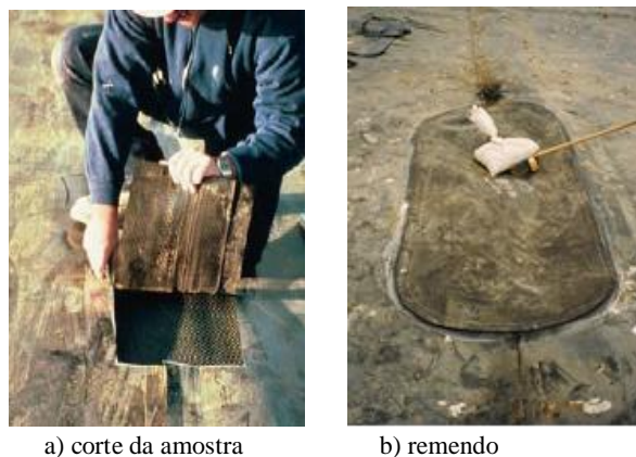
a) corte da amostra b) remendo
