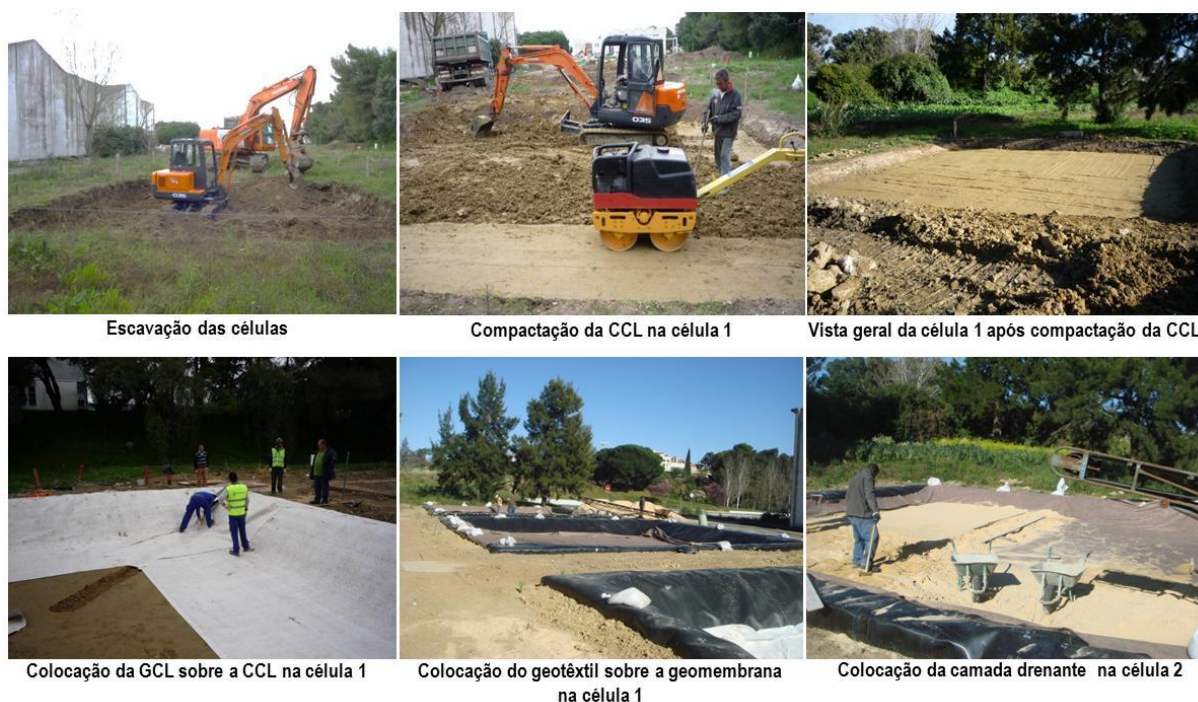
Figura 12 – Construção da Instalação Piloto no Campus do LNEC
