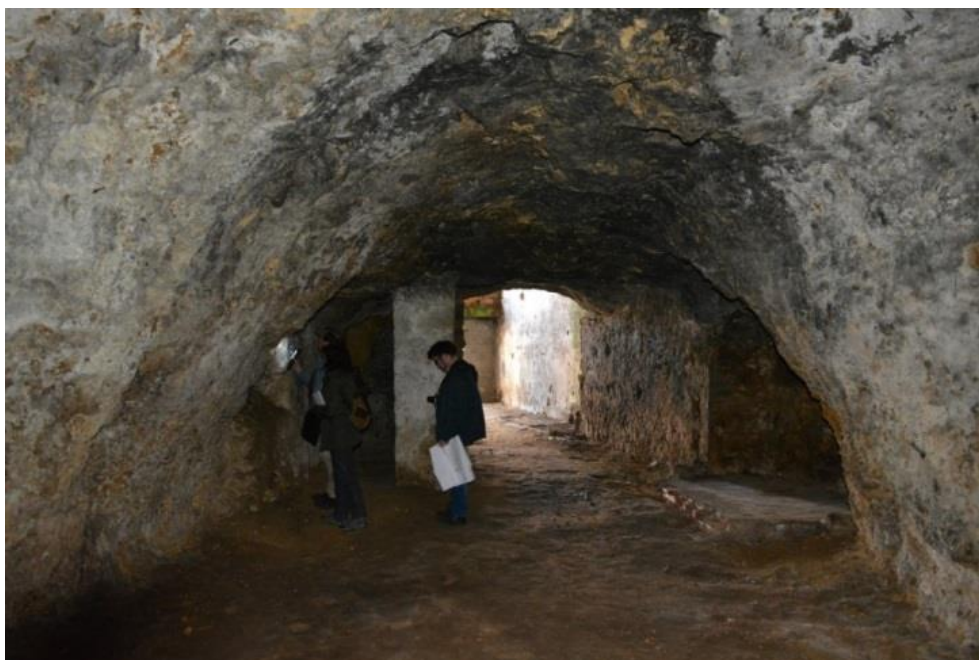
Figura 11 – Zona 1: vista da galeria de entrada
