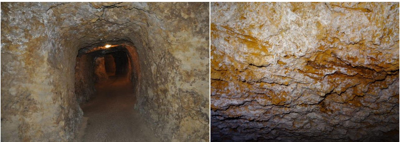
Figura 8 – Exemplos de alteração superficial no maciço rochoso
