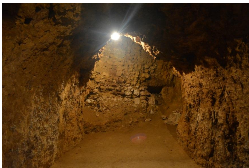
Figura 18 – Zona 7: vista da galeria de acesso ao depósito de vinho (DV)
