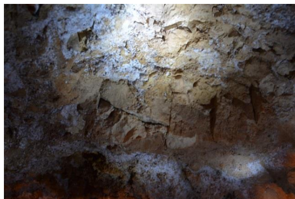
Figura 16 – Zona 5: vista do maciço exibindo um maior grau de compartimentação com a individualização de blocos entre os pilares 13 e 14
