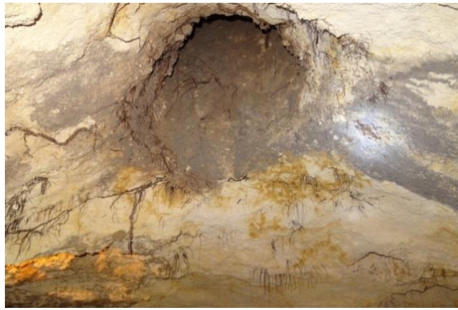
Figura 13 – Zona 3: vista do maciço nas imediações da chaminé CH3
