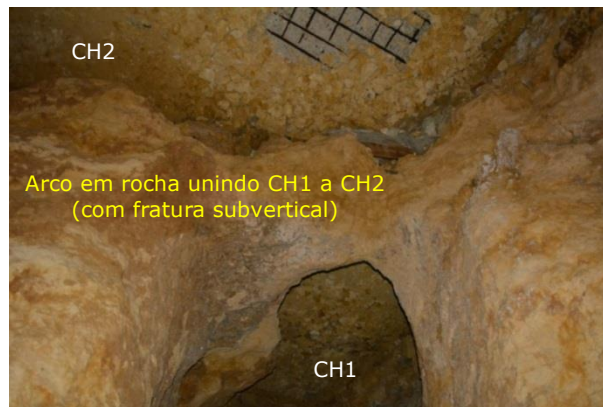
Figura 15 – Zona 4: vista das chaminés CH1 e CH2
