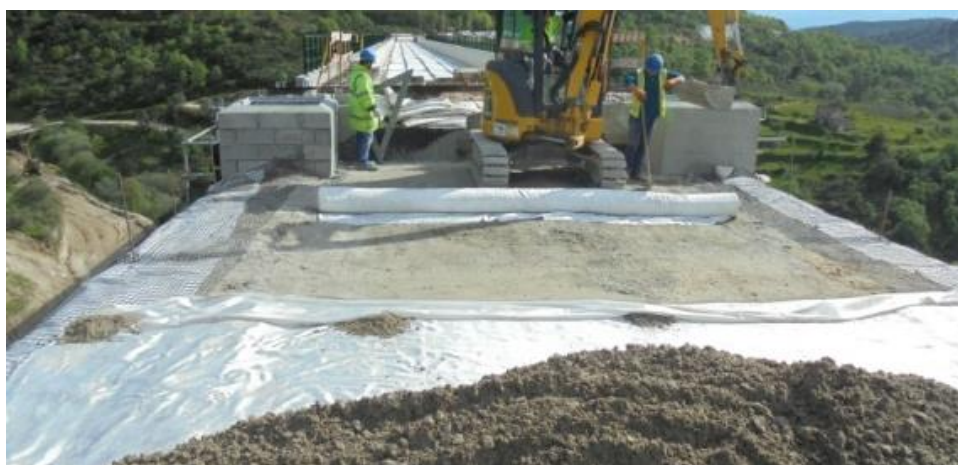
Figura 10 – Instalação do geotêxtil sob camada de sub-balastro
