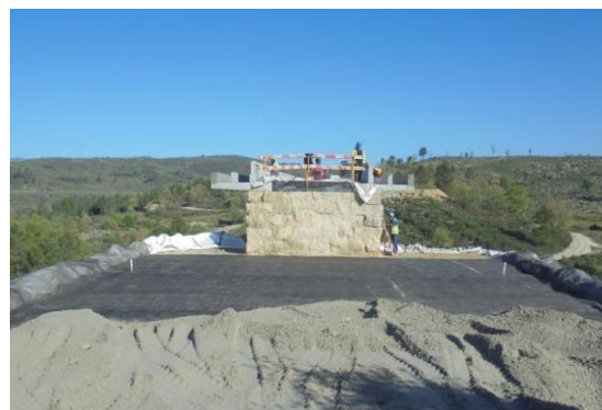
Figura 7 – Instalação da geogrelha no aterro do encontro da Ponte de Maçainhas
