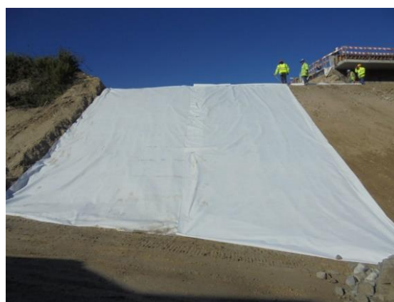
Figura 8 – Instalação do geotêxtil no talude do aterro do encontro da Ponte de Maçainhas
