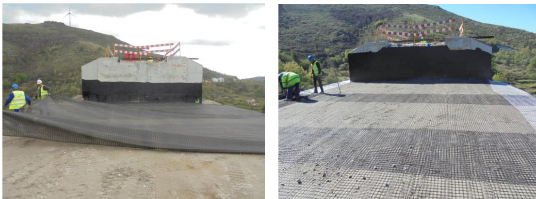
Figura 9 – Instalação da geogrelha no aterro do encontro da Ponte de Gogos
