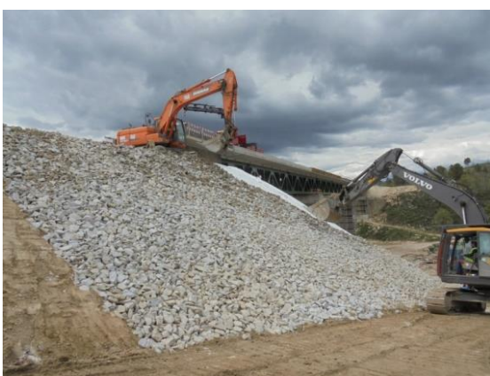
Figura 8 – Instalação do geotêxtil no talude do aterro do encontro da Ponte de Maçainhas
