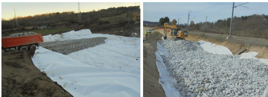
Figura 3 – Vista geral da colocação da camada de enrocamento sobre o geotêxtil
