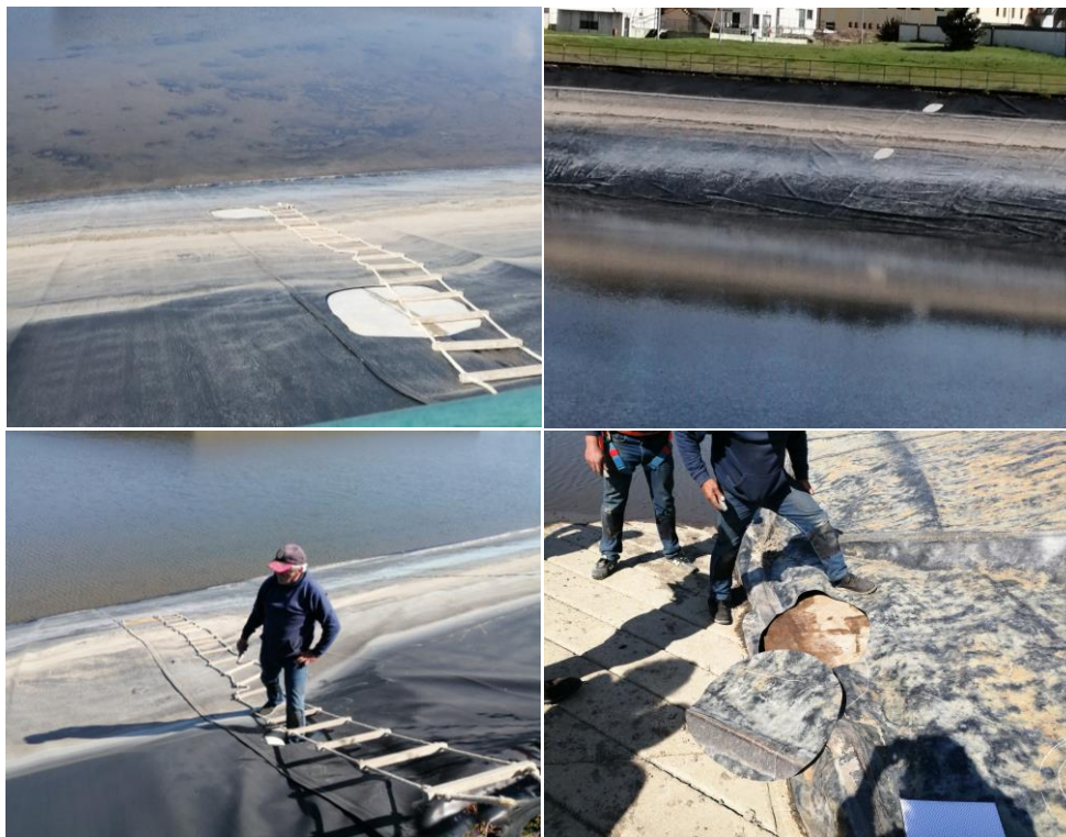
Figura 2 – Vista dos locais de amostragem nos diferentes taludes
