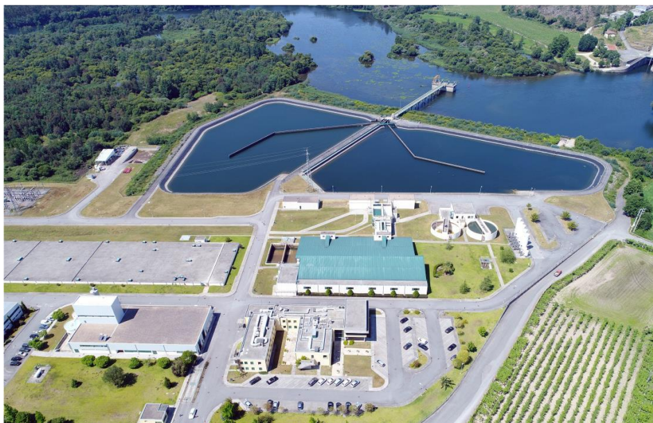
Figura 1 – Vista geral da ETA de Areias de Vilar
