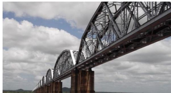
Fig. 4. Ponte Dona Ana: viga treliçada de 80 m
