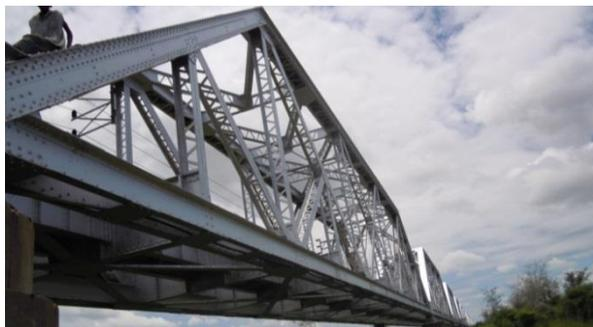
Fig. 3. Ponte Dona Ana: viga treliçada de 50 m
