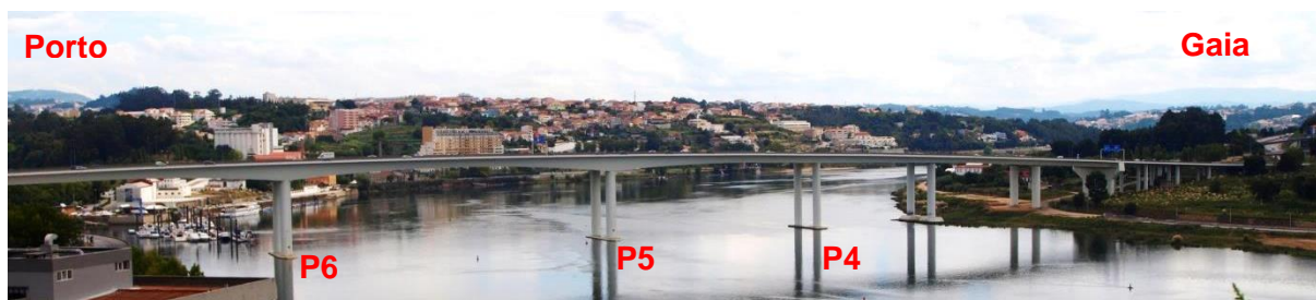
Figura 1. Alçado jusante da Ponte do Freixo
