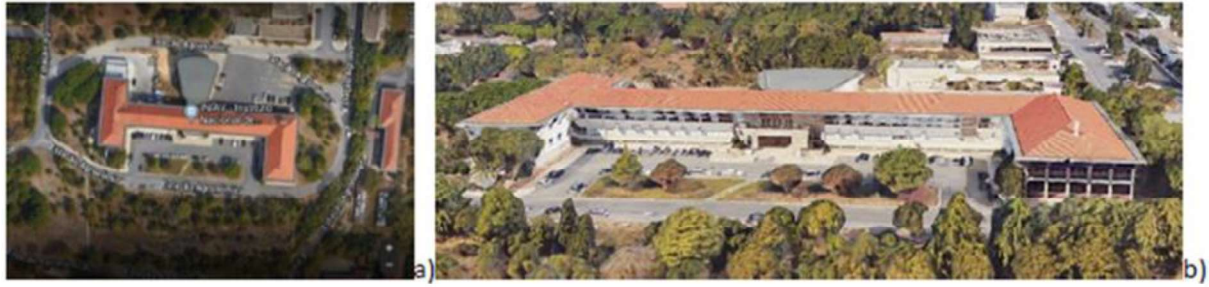
Figura 1 – Edifício do INIAV: a) Vista aérea (Google maps, 2019); b) perspetiva geral, adaptado (Silva, 2019)
