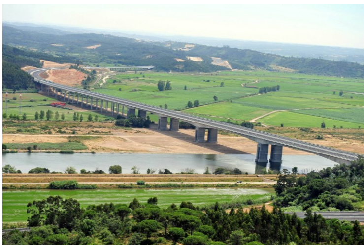
Figura 1 – Vista geral da ponte sobre o rio Mondego
