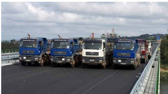
Figura 3 – Carregamento individual dos tramos
