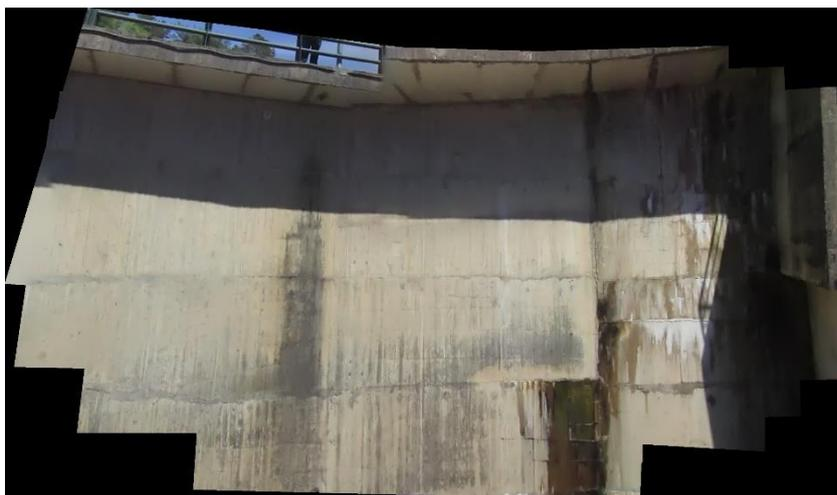
Figura 7 – Ortomosaico obtido com imagens captadas pela aeronave em ambiente operacional na barragem de Fagilde
