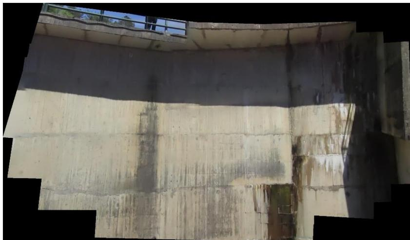
Figura 4 – Ortomosaico obtido com imagens capturadas pela aeronave em ambiente operacional na barragem de Fagilde
