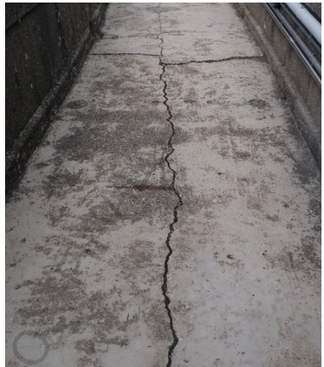
Figura 14 Barragem de Santa Luzia. Fendas na abóbada principal, no paramento de jusante em juntas de betonagem com depósitos de carbonatos de cálcio (à esquerda), e lineares no piso do coroamento, do lado da margem direita (à direita), em 2019
