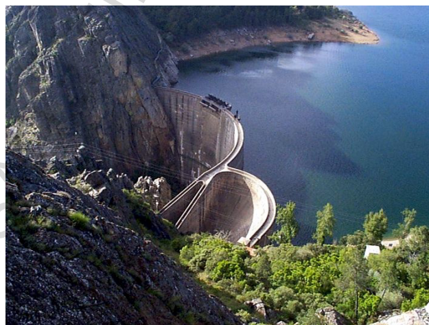
Figura 10 Barragem do Alto Ceira. Mapeamento de ocorrências no paramento de jusante, realizado em 2005, usando fotografia digital georreferenciada [7, 8]
