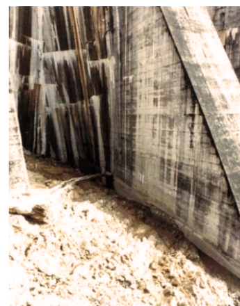
Figura 21 Barragem de Pracana. Fendilhação generalizada do paramento de montante e das almas dos contrafortes (fotografias captadas antes das obras de reabilitação)
