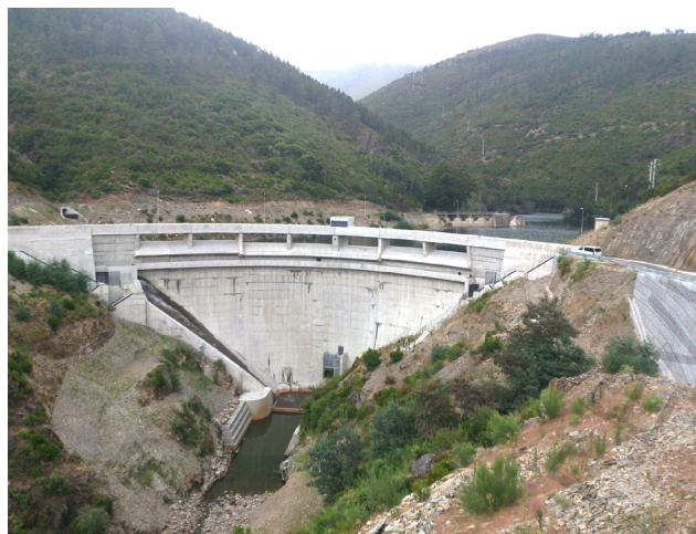
Figura 11 Barragem do Alto Ceira. Vista da nova barragem (designada por Alto Ceira II) e da barragem antiga parcialmente demolida, em julho de 2014, no final do primeiro enchimento da albufeira
