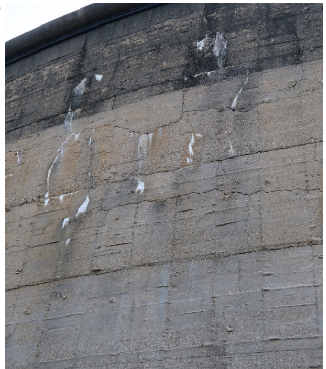
Figura 15 Barragem de Santa Luzia. Fendas muito abertas no coroamento, na zona de ligação entre a abóbada principal e o arco-gravidade (à esquerda) e fendilhação difusa no trecho superior do paramento de montante do arco-gravidade (à direita), em 2019
