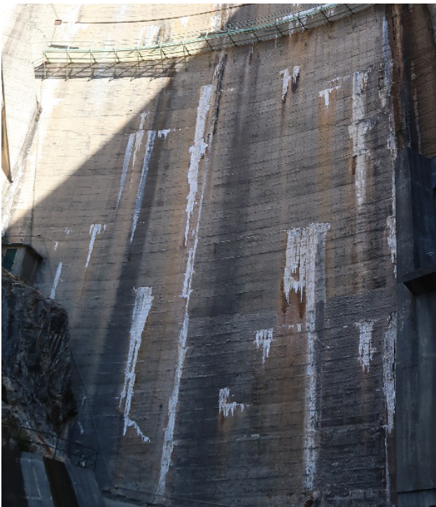
Figura 14 Barragem de Santa Luzia. Fendas na abóbada principal, no paramento de jusante em juntas de betonagem com depósitos de carbonatos de cálcio (à esquerda), e lineares no piso do coroamento, do lado da margem direita (à direita), em 2019
