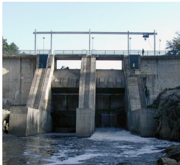
Figura 16 Barragem de Fagilde. Vista geral de jusante
