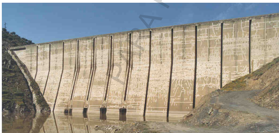
Figura 21 Barragem de Pracana. Fendilhação generalizada do paramento de montante e das almas dos contrafortes (fotografias captadas antes das obras de reabilitação)
