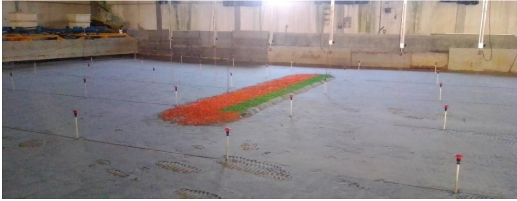
Figura 2.4 – Aspecto da construção do modelo físico, com a construção do QMD paralelo à linha de costa
