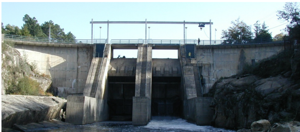
Figura 16. Barragem de Fagilde. Vista geral de jusante
