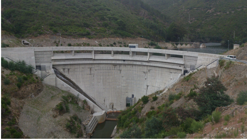
Figura 11. Barragem do Alto Ceira. Vista da nova barragem (designada por Alto Ceira II) e da barragem antiga parcialmente demolida, em julho de 2014, no final do primeiro enchimento da albufeira
