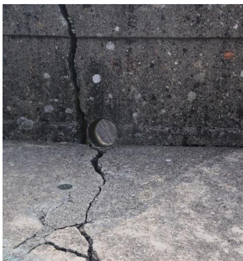
Figura 15. Barragem de Santa Luzia. Fendas muito abertas no coroamento, na zona de ligação entre a abóbada principal e o arco-gravidade (à esquerda) e fendilhação difusa no trecho superior do paramento de montante do arco-gravidade (à direita), em 2019
