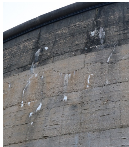
Figura 15. Barragem de Santa Luzia. Fendas muito abertas no coroamento, na zona de ligação entre a abóbada principal e o arco-gravidade (à esquerda) e fendilhação difusa no trecho superior do paramento de montante do arco-gravidade (à direita), em 2019
