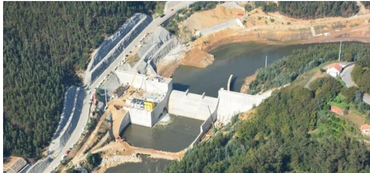
Figura 1. Vista aérea da barragem de Ermida
