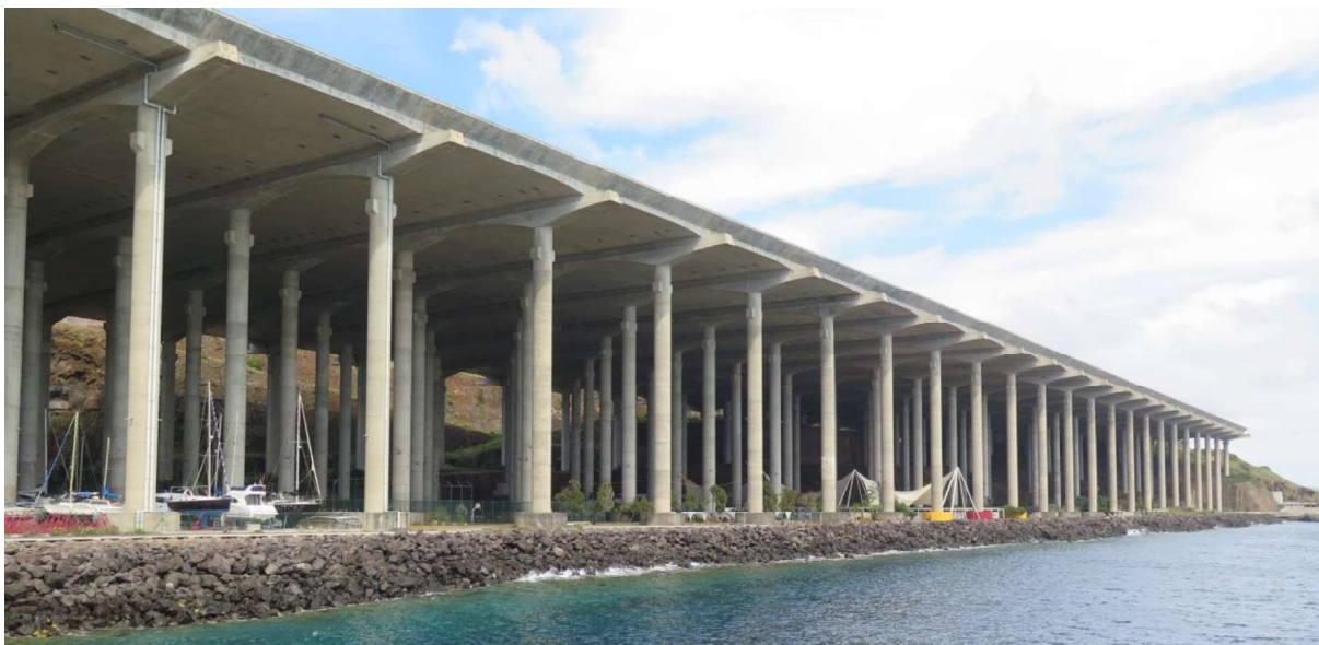
Figura 1. Vista geral da estrutura de ampliação da pista do Aeroporto da Madeira
