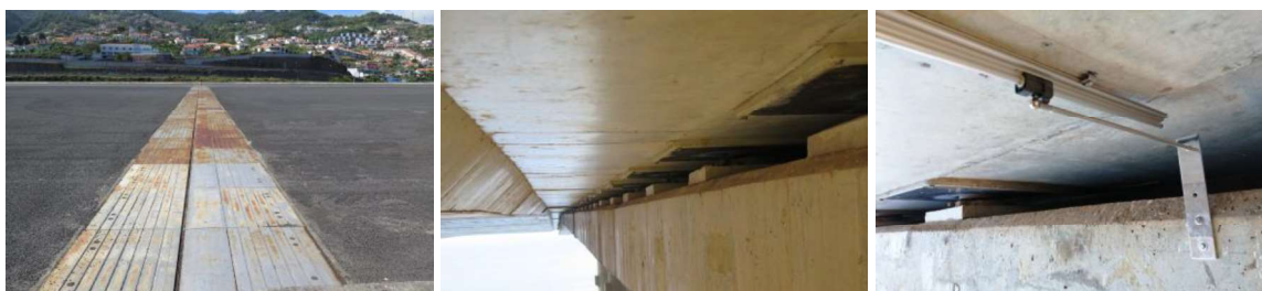
Figura 3. Junta de dilatação principal: vista geral e detalhe da instrumentação
