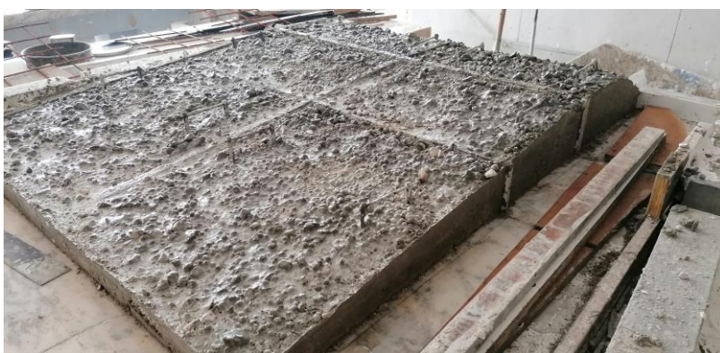
Figura 3.2 – a) Vista global do QMD implantado no tanque de ondas (a laranja o talude exterior e a verde a crista e talude interior); b) vista de uma peça da construção do QMD, do talude a barlar
