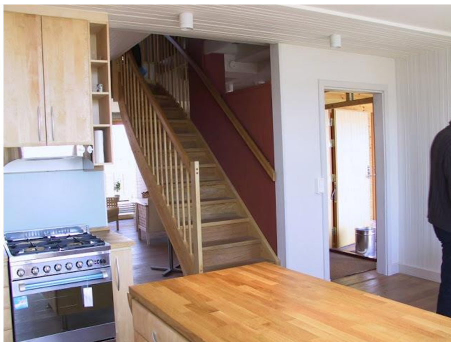
Fig. 03: Escada doméstica de habitação do conjunto urbano "Bo01 City of Tomorrow", desenvolvido no âmbito da exposição que teve lugar em Malmö em 2001 (ver nota final) - Arquitetura: autoria não identificada – fica evidenciado algum sentido de recato e de pormenorização “tradicional” na integração da mesma, mas também se evidencia a segurança proporcionada pelas guardas verticais pouco espaçadas e pelos corrimãos bilaterais.
