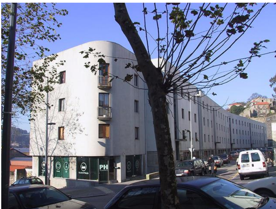
Fig. 03 – 1995, Cooperativa de Habitação de Massarelos, Porto, um excelente conjunto de 95 habitações onde o desenho se alia à apropriação; projeto dos Arquitetos Francisco Barata e Manuel Fernandes de Sá.
