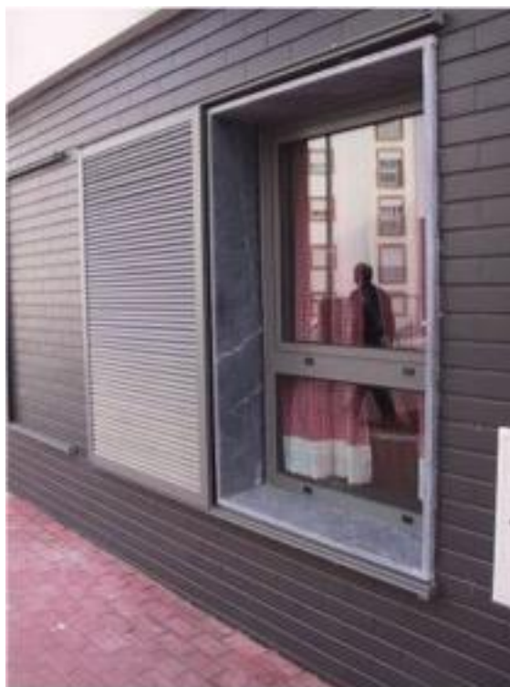
Fig. 16: um pormenor do conjunto de 52 fogos no Outeiro da Forca, Portalegre, uma promoção da C.M. de Portalegre com projeto do Arq.º Carlos Gonçalves (2007); na imagem um pormenor do funcional e digno/bem integrado processo de proteção utilizado nas janelas dos fogos térreos; nem é complicado, basta projetar, sistematicamente, com atenção e qualidade, não deixando questões por resolver.
