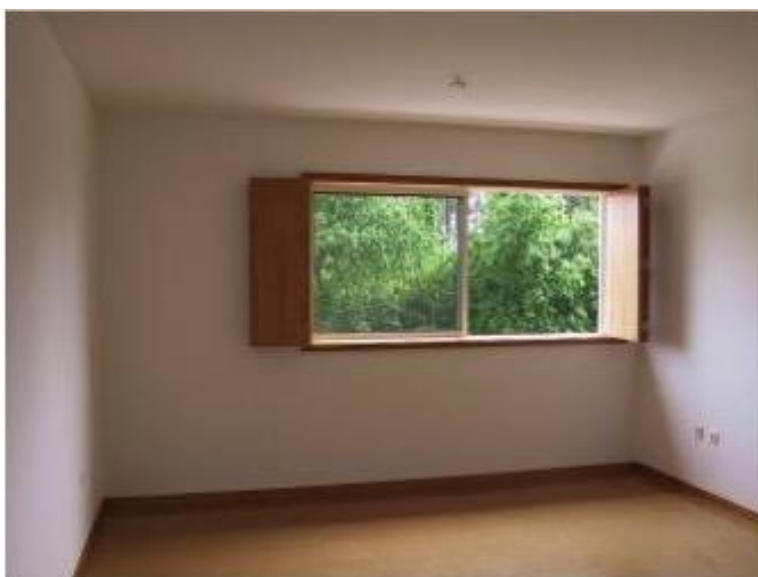
Fig. 11: um pormenor do interior de um dos fogos do edifício promovido pela Câmara Municipal de Espinho na Rua do Coteiro em Espinho (2005), com projeto do Arq.º Carlos Nuno Lacerda Lopes; neste caso um pormenor que foca o extenso e pormenorizado cuidado que foi investido na pormenorização das janelas das habitações, que aqui cumprem, metodicamente, todas as suas melhores funções, designadamente, em termos de vistas exteriores, proteção interior, ventilação natural e funcionalidade no uso e na manutenção.
