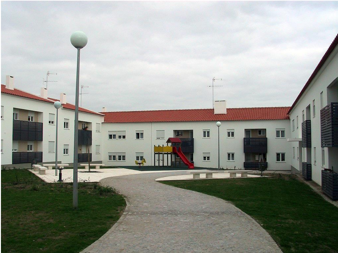
Fig. 3: conjunto de 45 fogos da cooperativa CHC na Senhora da Saúde em Évora, Arq. Rui Russo (2005); pequena intervenção de realojamento para pessoas muito carenciadas e que foi realizada por uma cooperativa, ficando evidenciada a relação entre a simplicidade do edificado, a dignidade e a forte escala humana do conjunto; o exterior complementa os usos do interior doméstico, em termos do recreio de crianças, logo ali bem perto das janelas das habitações.
