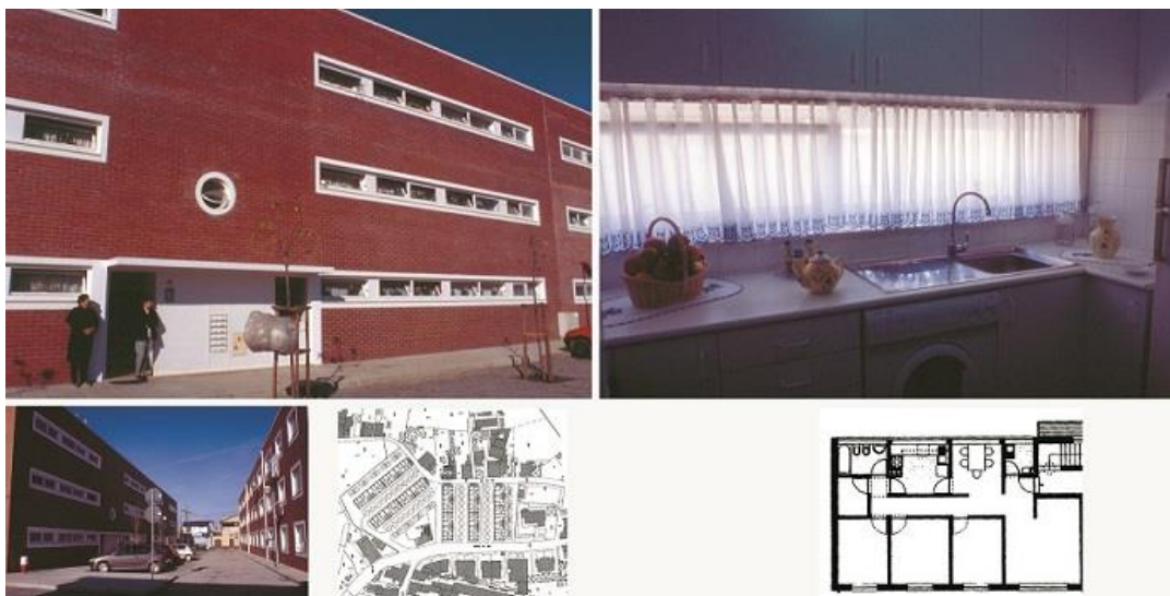
Fig. 8: em 1999, na Rua do Chouso, em Santa Cruz, num conjunto residencial de realojamento da Câmara Municipal de Matosinhos, projetado pelo Arq. Luís Miranda, concretizou-se uma solução que integra escala humana e urbana, adequação a quem aí habita e revitalização da zona onde se integra. O conjunto caracteriza-se pela integração urbana e volumétrica na envolvente, com edifícios baixos e regulares. Criam-se pequenas bolsas de estacionamento e acesso local, arborizadas e com
