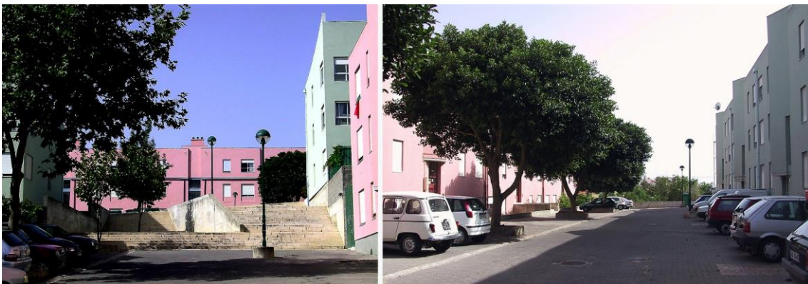
Fig. 2: depois de em 1991 ter sido concretizado o que se julga ser uma das melhores promoções municipais portuguesas do século XX, o conjunto urbano e residencial de realojamento da Câmara de Oeiras, em Laveiras/Caxias (cerca de 400 fogos), por Nuno Teotónio Pereira e Pedro Botelho, em 1993, no Alto da Loba em Paço de Arcos (ilustrada nas imagens), numa nova promoção municipal de Oeiras, com 330 fogos, concebida também por Pedro Botelho e Nuno Teotónio Pereira, é aplicada uma solução com o mesmo tipo de edifícios (pequenos multifamiliares), num conjunto
