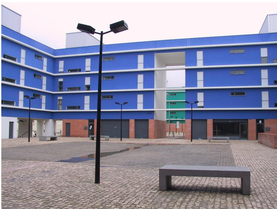
Fig. 5: o conjunto de 91 fogos de realojamento da Câmara Municipal de Lisboa na Travessa do Sargento Abílio, Benfica (2001), com projeto de Paulo Tormenta Pinto, é um excelente exemplo de humanização e urbanidade, que ainda contribuiu com o seu desenho urbano para a estruturação da zona onde se implantou. A solução do edificado, “simplesmente”, produz uma imagem urbana global, simultaneamente unificada e diversificada, associada a uma pormenorização dos espaços públicos, que é, simultaneamente, uma pormenorização dos acessos aos edifícios, mas, depois o edifício apaga-se agradavelmente no quarteirão e podemos, logo, antecipar os espaços domésticos inovadores onde se associam sala e cozinha e onde a marcação da cozinha na fachada é estrategicamente diluída.
