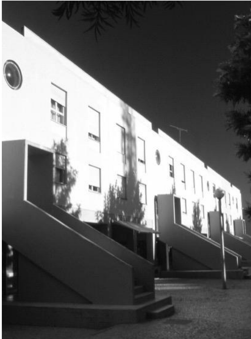
Figura 1: Pormenor do grande e excelente conjunto de 400 fogos e vários equipamentos em Laveiras, Caxias, promovido pela Câmara Municipal de Oeiras, com projecto dos arquitectos Nuno Teotónio Pereira e Pedro Botelho, 1991.
