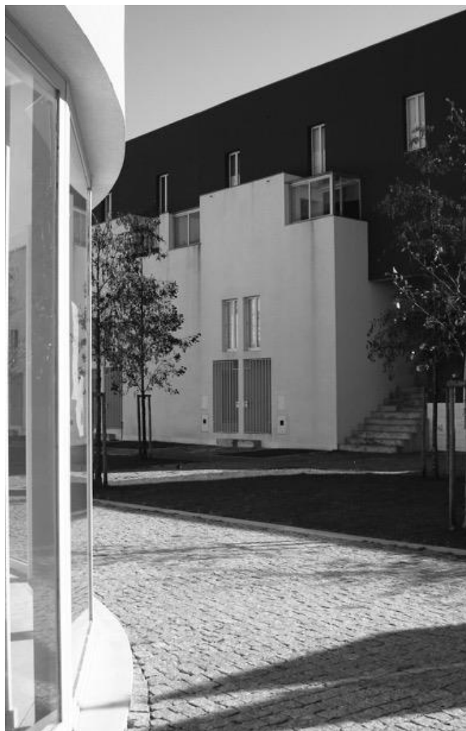
Figura 3: Pormenor do conjunto de 72 fogos na Bouça, Porto, concluído através da iniciativa cooperativa habitacional, Cooperativa Águas Férreas, projeto dos arquitectos Siza Vieira e António Madureira, 2006.
