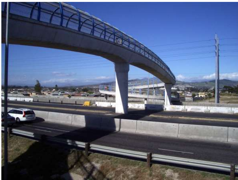
Figura 2.22 – Passagem de peões superior com rampa (Foto: Cardoso, J. L.)
