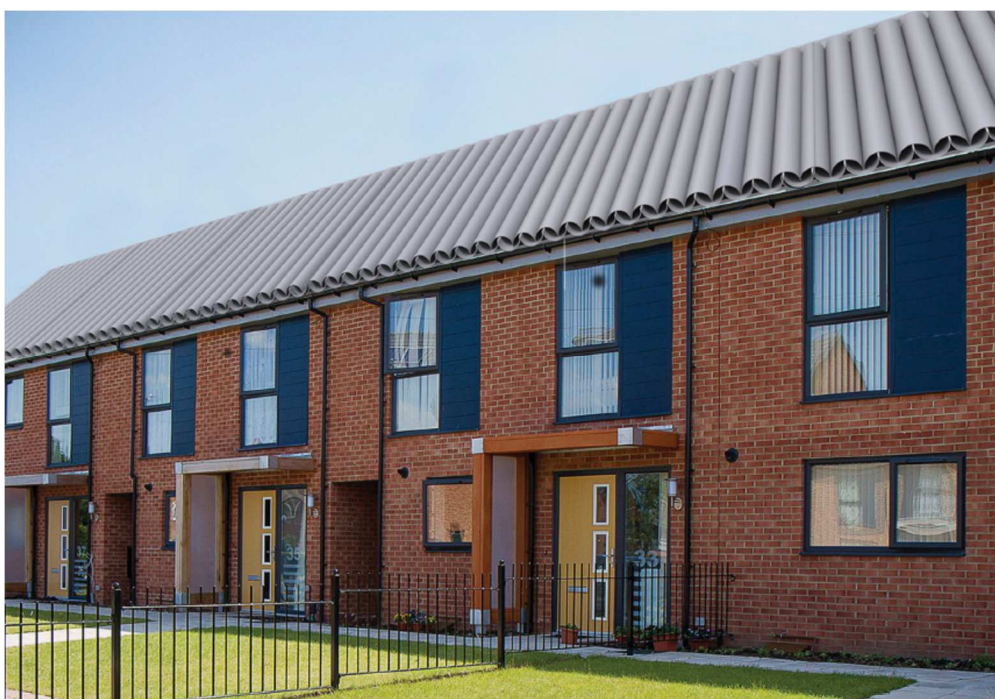
Figura 12.5 – Desenho auto-cad de um conjunto de vivendas geminadas com o telhado constituído pelo sistema pré-fabricado de recolha de água da chuva da Tectum (Kristen Tapping, 2021)
