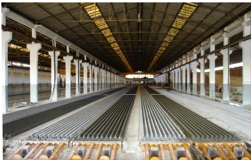
Figura 3.1 – Mesa de cofragem para o fabrico de vigotas
