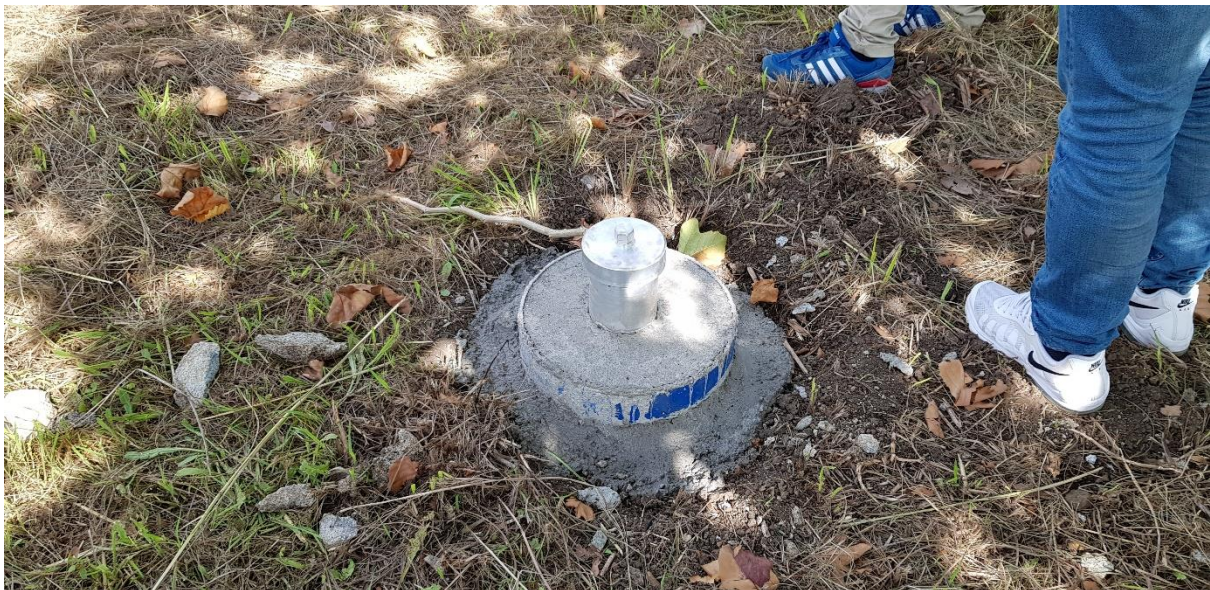
Figura 4.7 – Fotografia do piezómetro S5B, a sul do Site 5001
